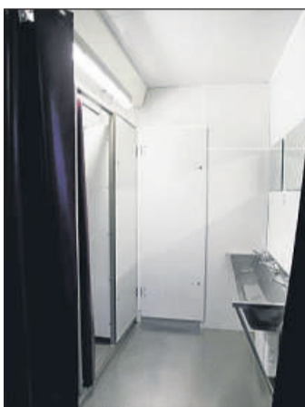
Kaum genutzt: Der Duschcontainer ist eng und wenig einladend. Foto: Schräfer
