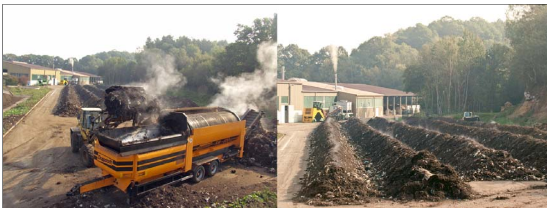
Abb. 6: Biokompostierungsanlage Lohfelden: Kompostabsiebung u. Nachrottefläche
