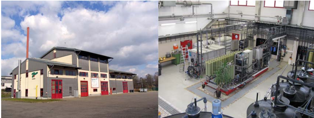
Abb. 4: Umweltfabrik mit Sickerwasserreinigungsanlage (Umkehrosmose)
