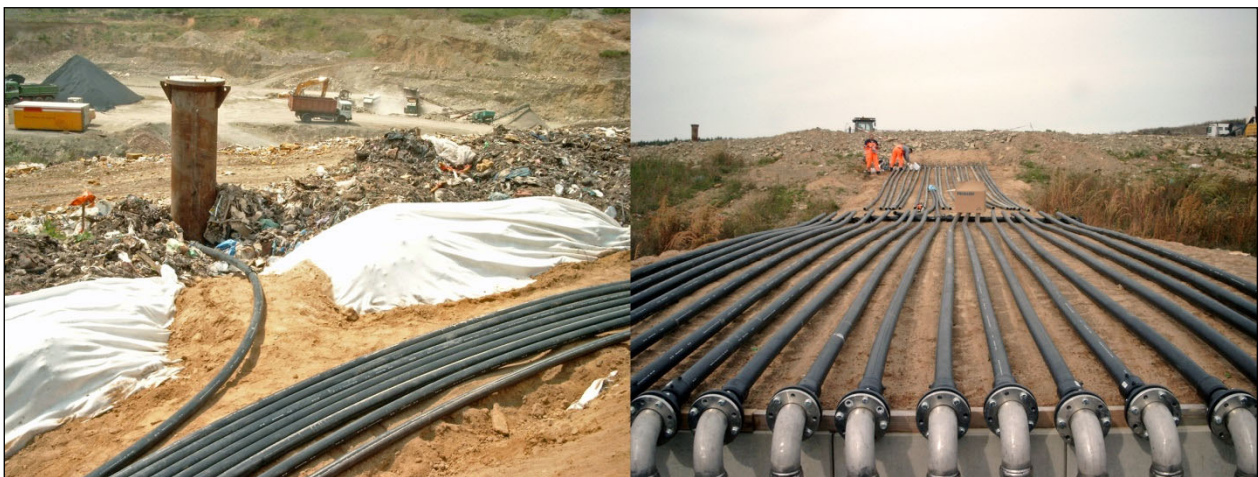
Abb 3.29: Verlegung von Gasleitungen im Deponiekörper (hier Sektor 3)
