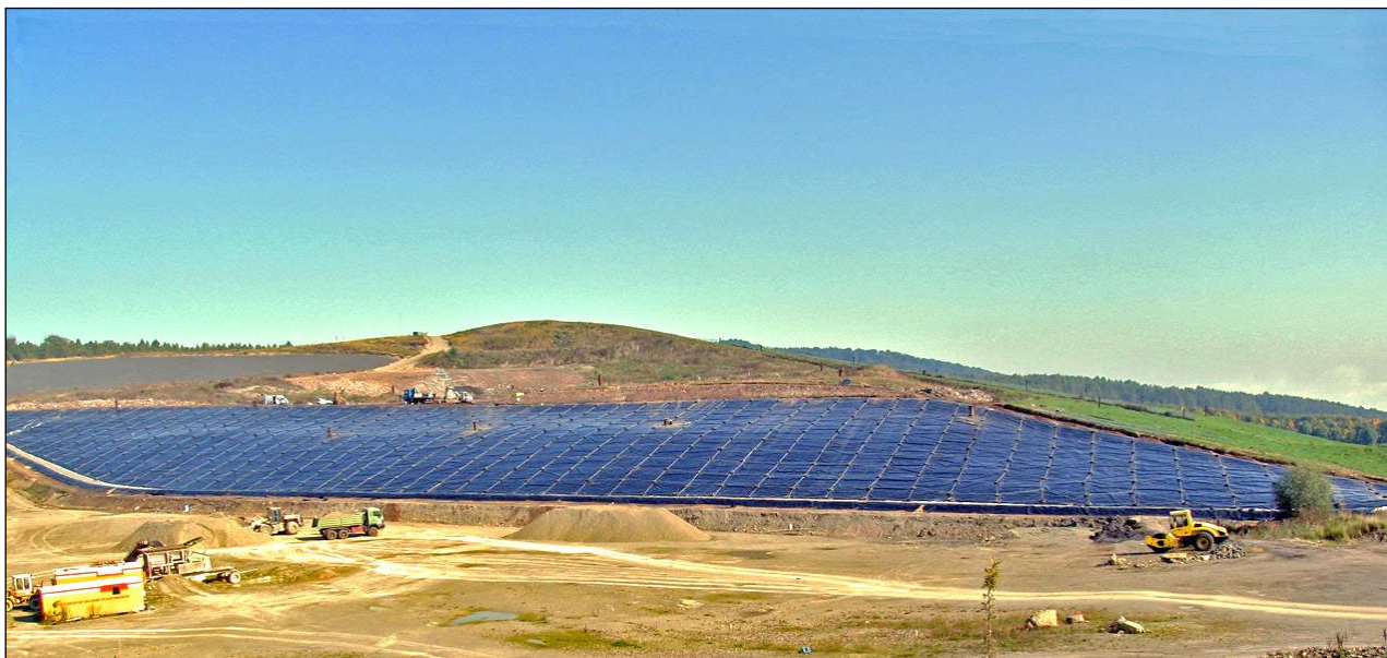
Abb. 3 - 15: Abdeckung der Westböschung mit verschweißten Kunststoffdichtungsbahnen
