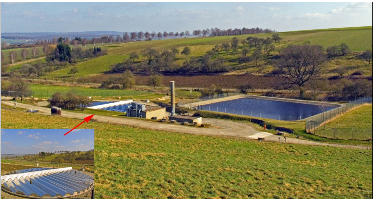
Abb. 3 - 23: Anordnung der Sickerwasserspeicherbecken; kleines Bild: neue Abdeckung
