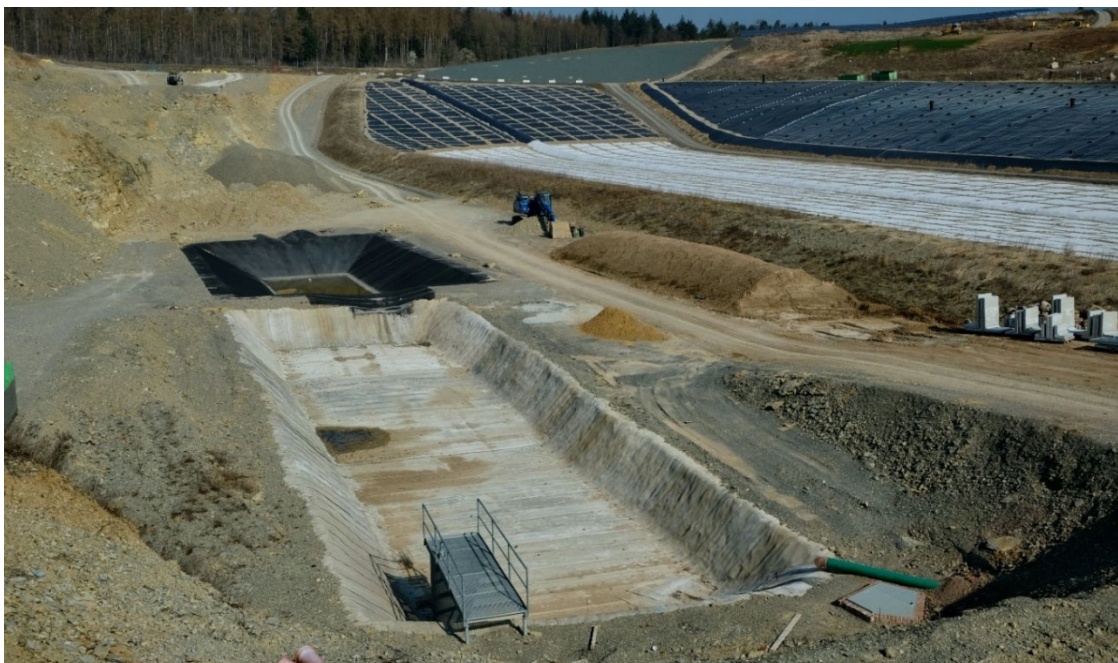
Abb. 3 - 2: Sedimentations- und Retentionsbecken Einleitstelle Süd
