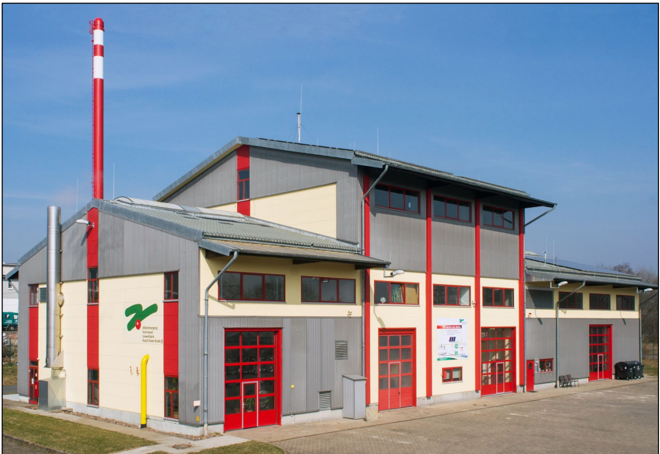
Abb. 3 - 1: Umweltfabrik (Deponiegasnutzungs- und der Sickerwasserreinigungsanlage)
