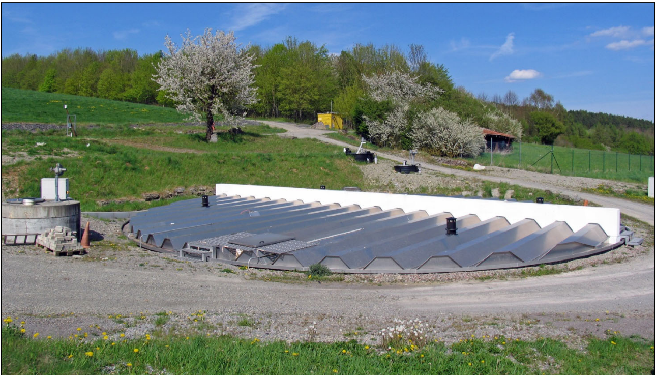
Abb. 3 - 22: Sickerwasserspeicherbecken, Fassungsvermögen 800 m 3
