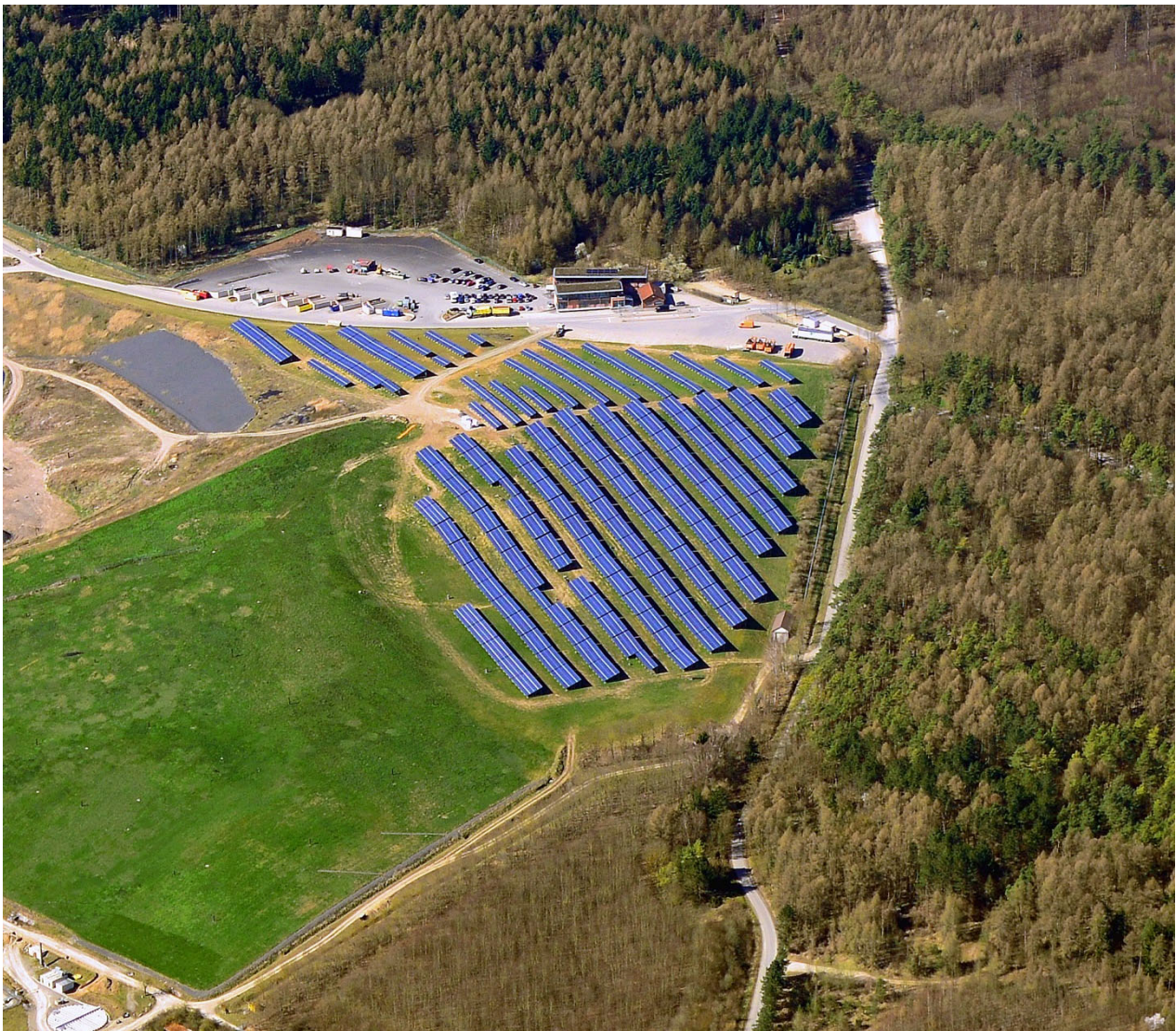
Abb. 3 - 18: Photovoltaikanlage auf der Oberflächenabdichtung der Altdeponie
